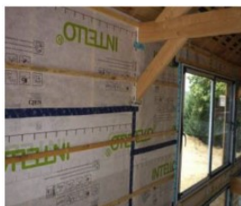
Frein-vapeur pour l'étanchéité des parois
