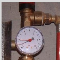
Manomètre indiquant la pression du circuit
