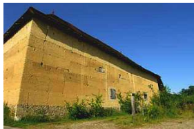
Exemple de bâtiment n'ayant pas été enduit depuis sa construction. Le pisé n'a pas subi d'altération due à l'érosion.
