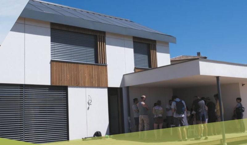
Visite d'une construction passive à Villié-Morgon
