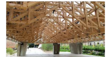
Mise en oeuvre construction, chauffage
