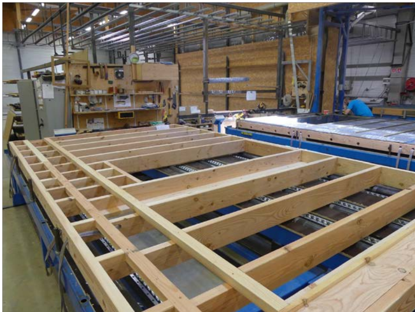
Préfabrication en atelier
